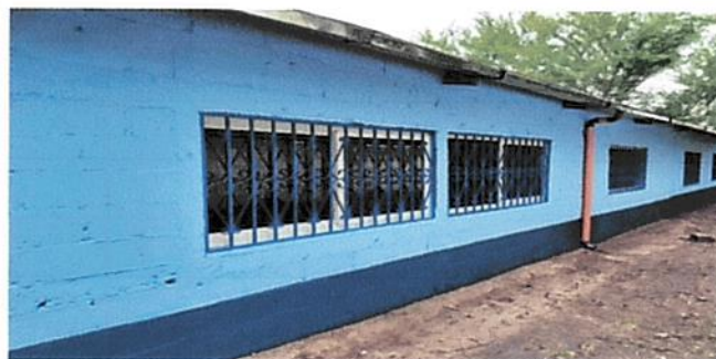
Foto 2: Colocación de canales y bajadas de agua
