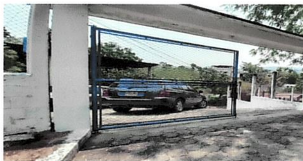
Foto 6: Reparación de portón de acceso principal.
