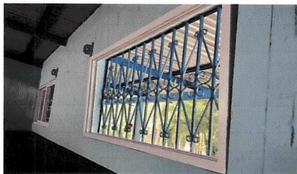
Foto 4: Instalación de ventanas de PVC
