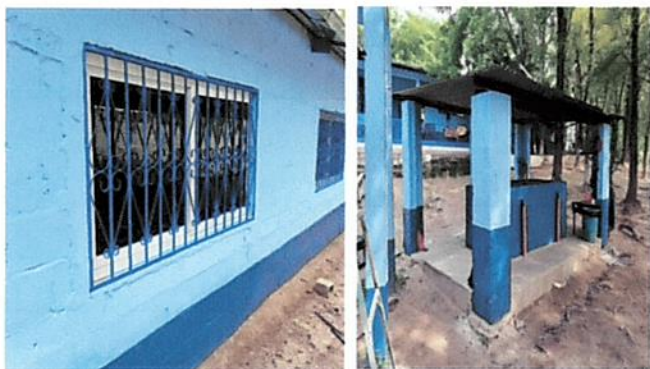
Foto 3: Pintura en interior y exterior del centro educativo.
