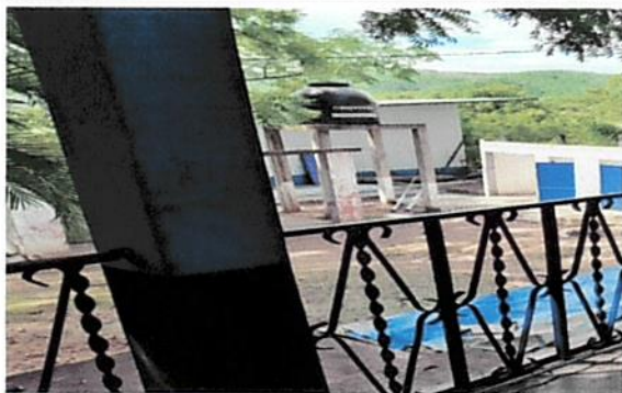
Foto 5: Mantenimiento de balcones y puertas.
